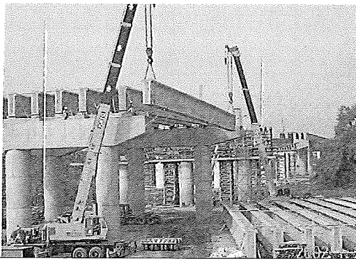
照片 9：預力梁之預鑄與吊放作業
