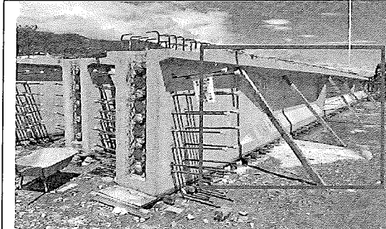
照片 5：吊放前-斜撐可均佈於梁身
