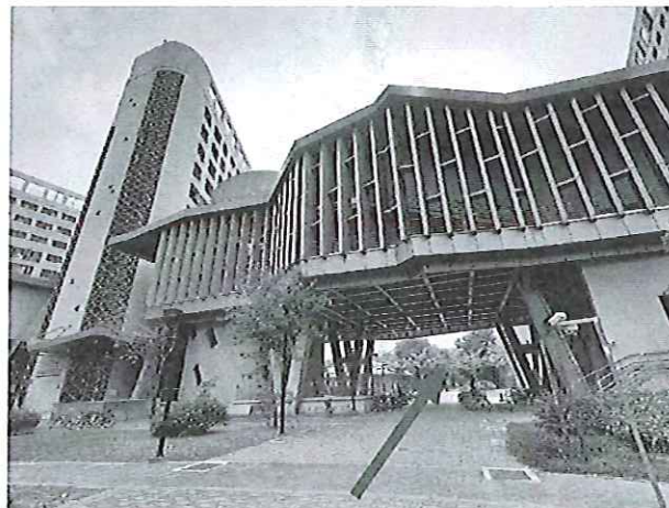
(2) 進入空橋下方
