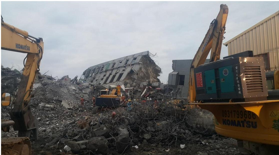
圖二十二 東二區 BCED 棟 高樓層機械拆除(梁詩桐 提供)
