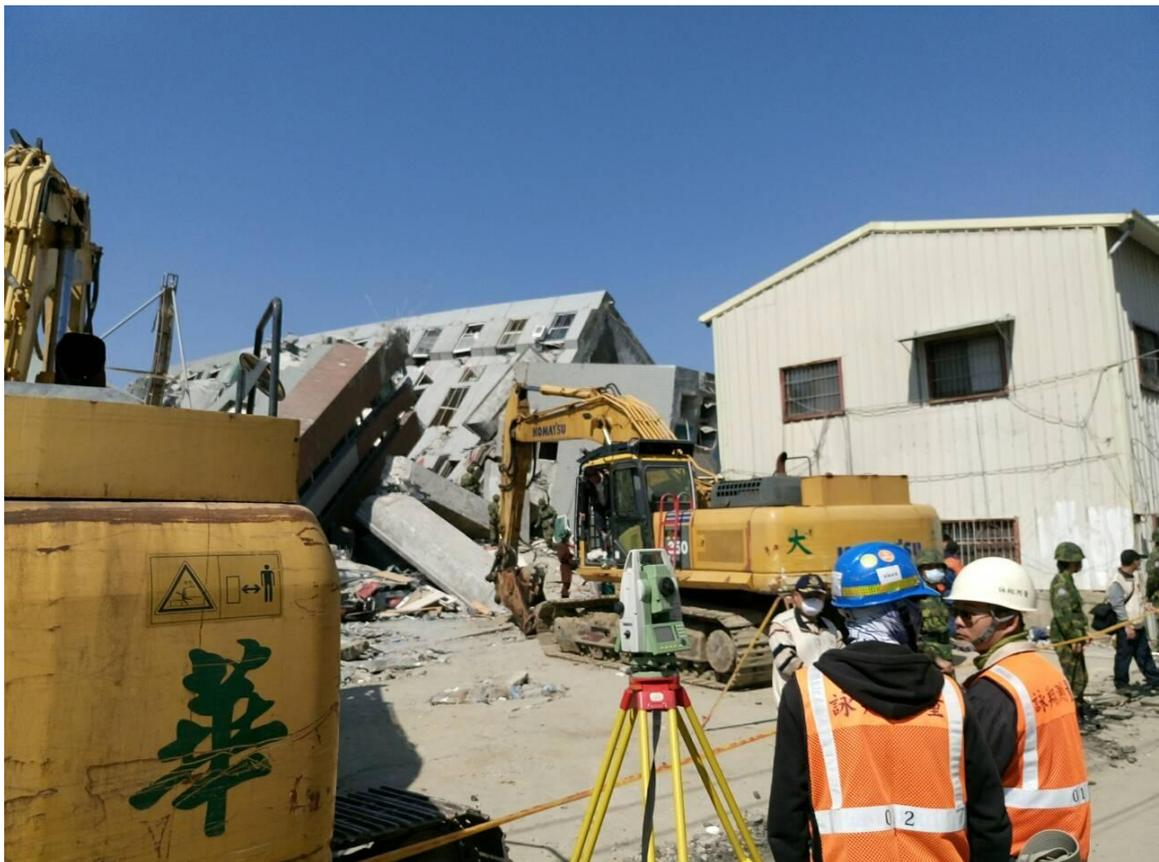
**圖十三 機械拆除使用經緯儀觀測房屋傾倒確保穩定(朱弘家提供)**
