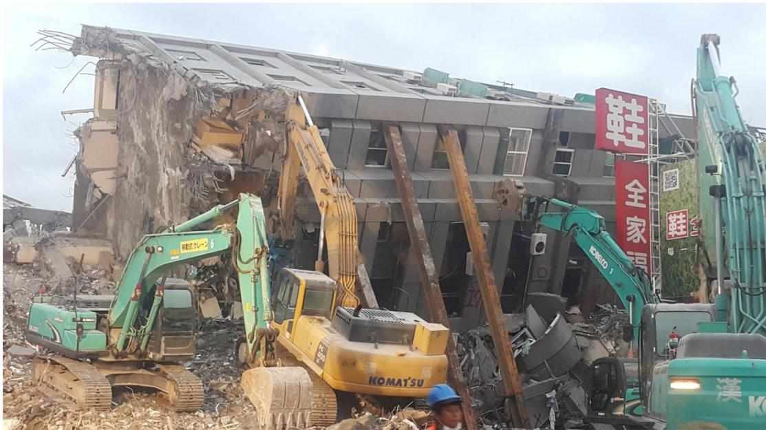
**圖十八 北一區 I 棟 高樓層以大鋼牙拆除輔以鋼梁及怪手支撐確保穩定 (梁詩桐 提供)**
