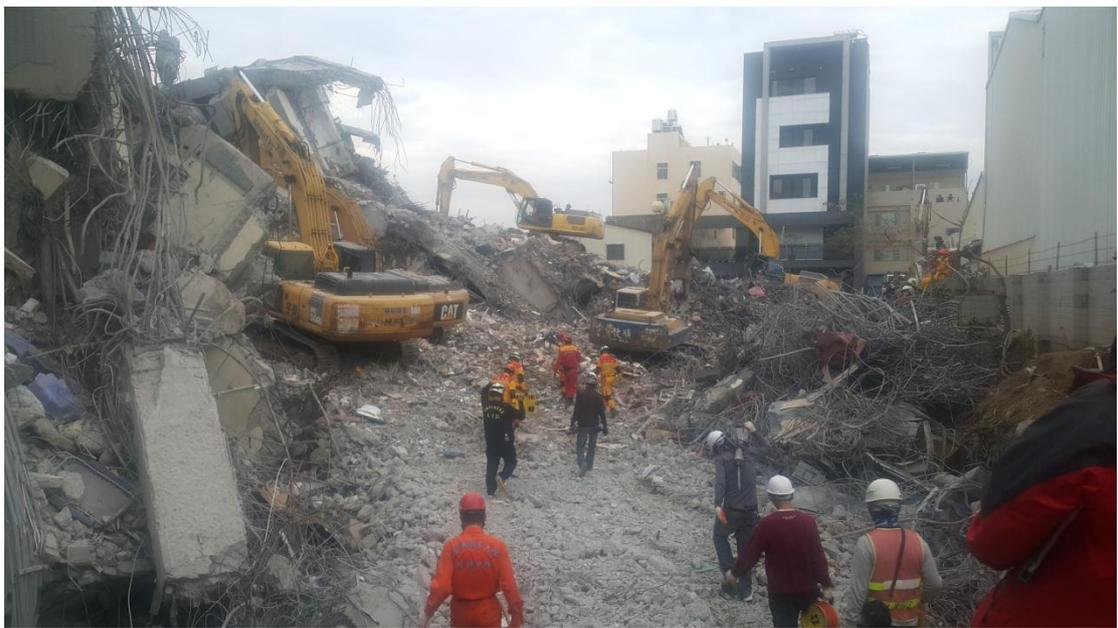
圖二十 西四區 BCDEF 棟 低樓層機械拆除(梁詩桐 提供)
