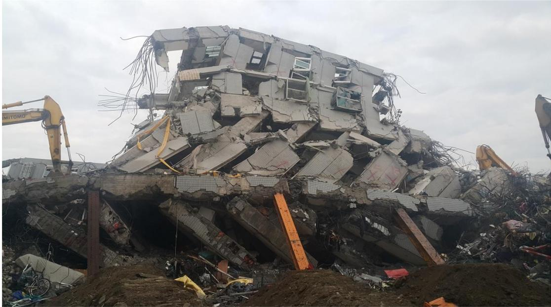
圖二十一 南三區 H(上)A(下)棟堆疊以堆土及鋼梁斜撐穩定(梁詩桐 提供)
