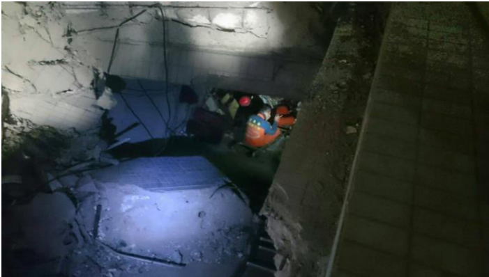
◀ 曾永裕與許智泰技師進入B6內部所拍的照片
